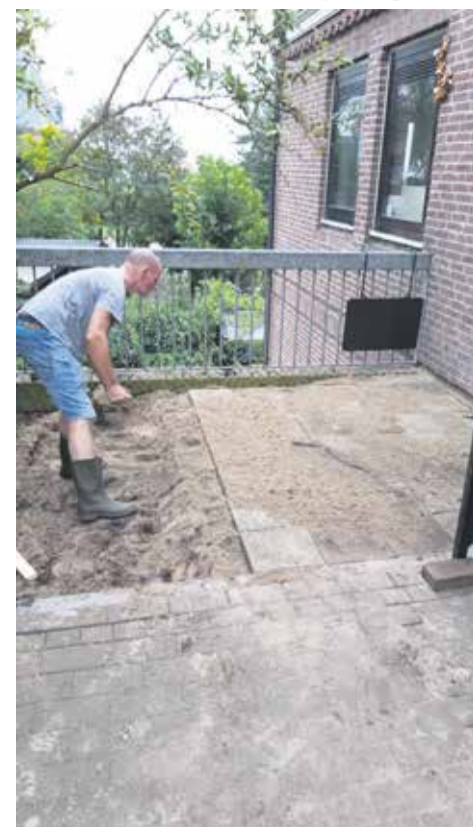
Foto: Leo druk aan het werk met de aanleg van het terrasje.
